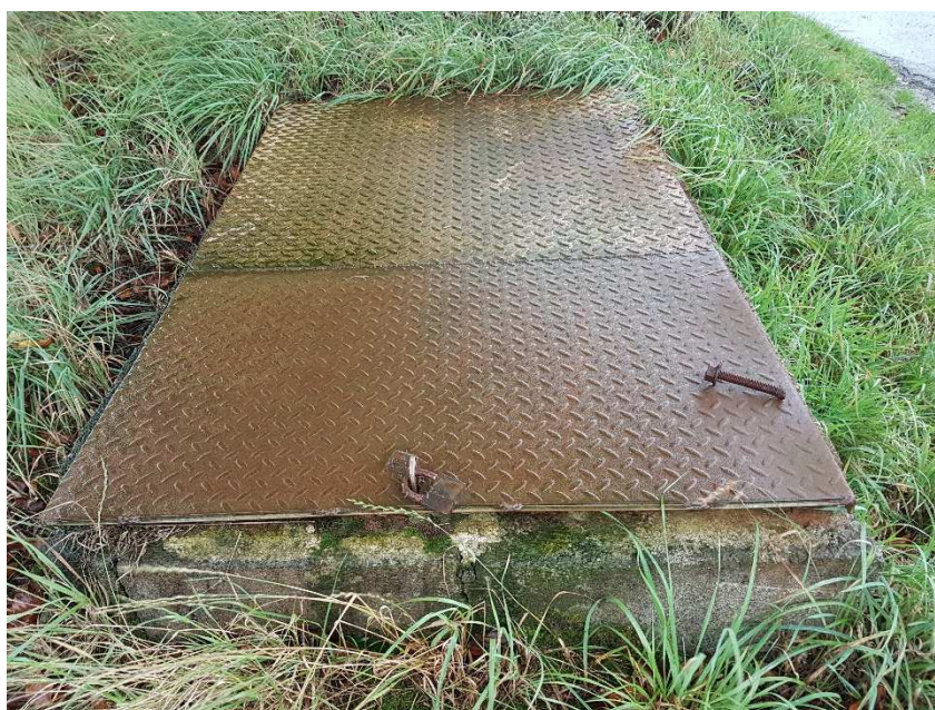
Figure 5. Tête du forage n°1
